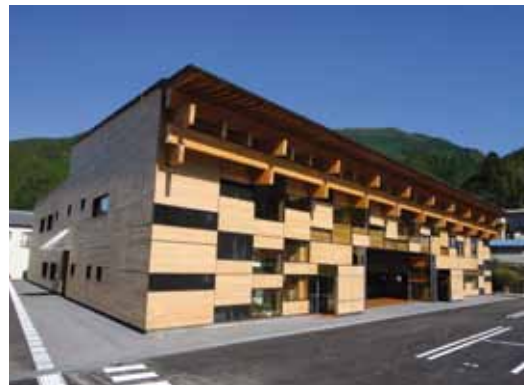
梶原町総合庁舎(役場庁舎)
